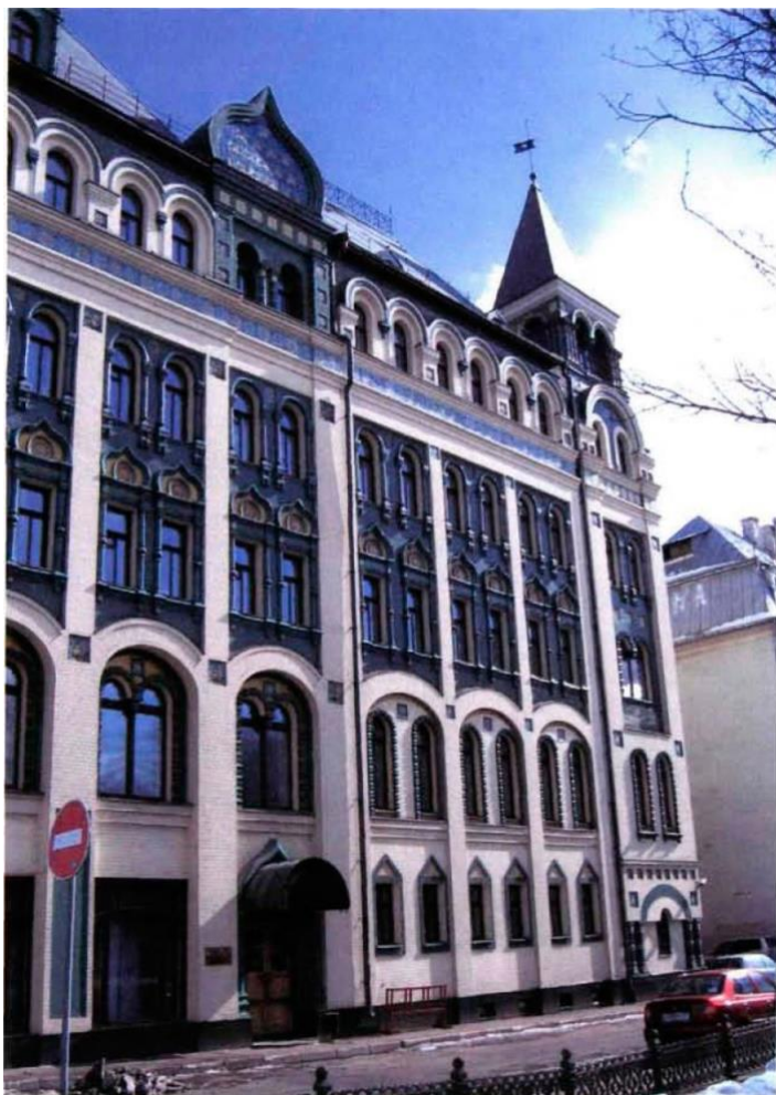
Рис.1. Состояние облицовочного кирпичного слоя в здании, построенном в 1895-1900гг. в г. Москве.
