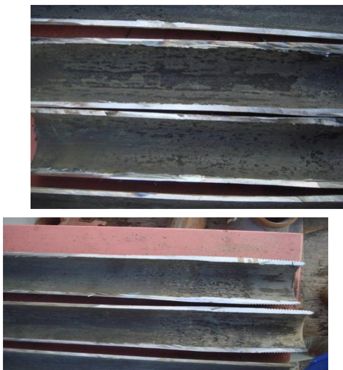
Рис. 5 – Коррозия внутренней поверхности НКТ из ст. 26ХМФА2
