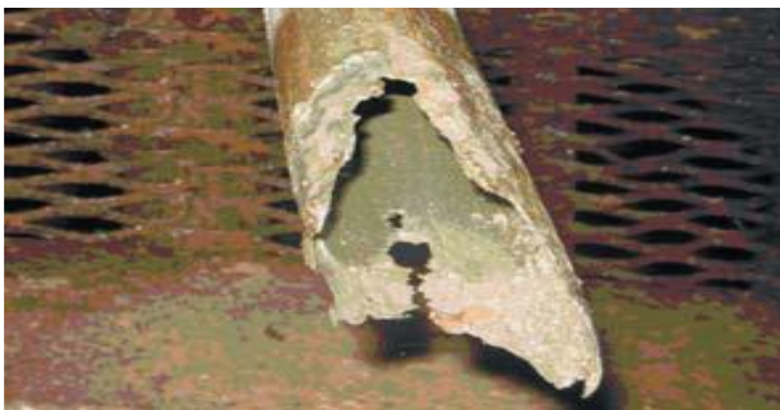
Рис. 13 – Коррозия НКТ под воздействием СКО (Южно-Харампурское месторождение)
