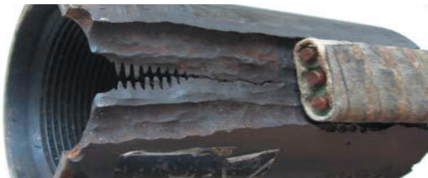
Рис. 11 – Электрокоррозия муфты НКТ при закачке ИСО через затруб (Мамонтовское месторождение)
